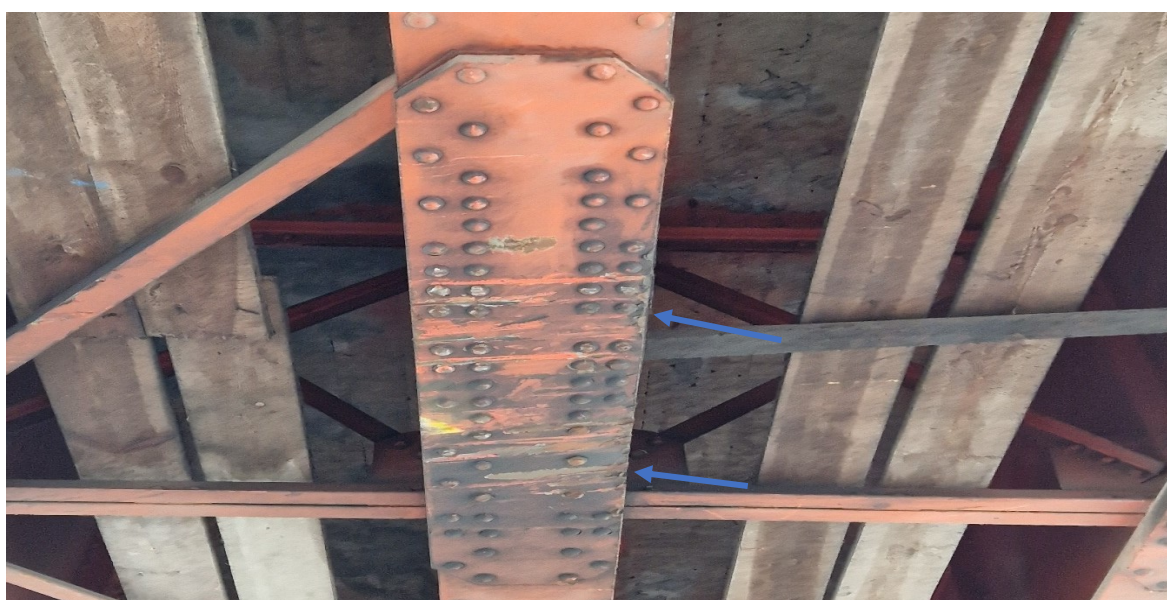
13.27 nuotrauka. Pirmojo tarpatramio perdangos 6 sijos virš važiuojamosios dalies mazginio lakšto bendras vaizdas žiūrint iš apačios. Mazge nukirptų kniedžių galvučių nėra, tačiau nubrozintos 14 kniedžių galvutės ir pažeista apatinio lakšto apsauginė dažų danga bei apdaužytas lakšto kraštas žiūrint nuo žemupio pusės
