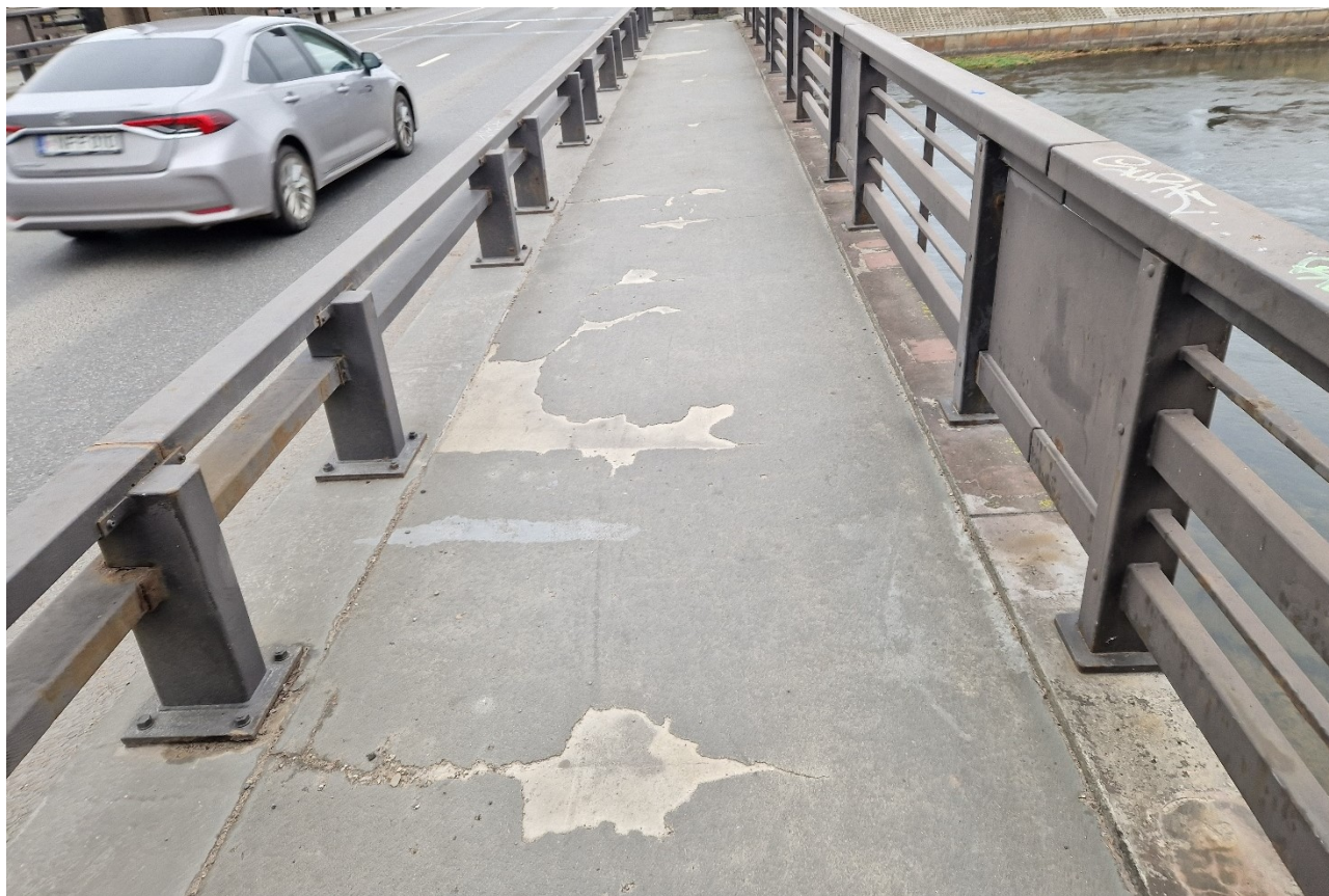
13.5 nuotrauka. Šalitilčio einamosios dalies dangos bendras vaizdas aukštupio pusėje netoli tilto vidurio. Dideliais plotais atšokusi ir nusilupusi apsauginė einamosios dalies danga
