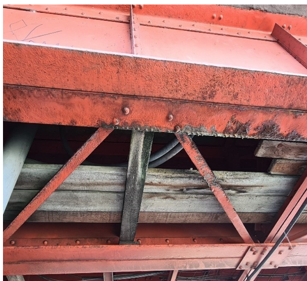
13.31 nuotrauka. Sijų ryšiai ir sijos po kiaurais deformaciniais pjūviais ir po blogai nuvestais vandens nuleidimu nuo hidroizoliacijos šulinėliais intensyviai koroduoja, pirmame tarpatramyje yra palankstytų ryšių
