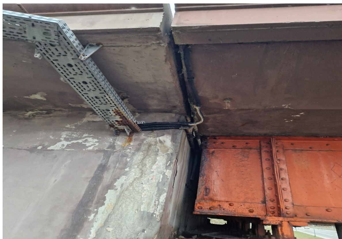
13.33 nuotrauka. I atramos bendras vaizdas žiūrint nuo aukštupio pusės. Dėl kiauro deformacinio pjūvio šlampa ramto rygelis, atkaltė ir sparnas. Ramto paviršiuje matyti vandens tekėjimo žymės ir išsisunkę karbonatiniai produktai
