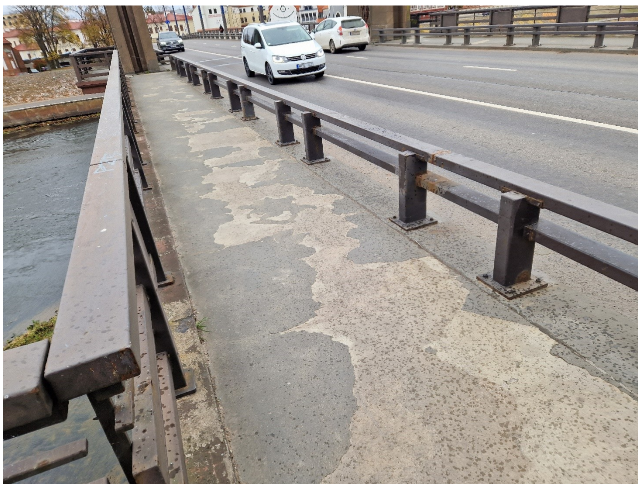
13.7 nuotrauka. Žemupio pusės šaltitilčio einamosios dalies bendras vaizdas. Dideliais plotais atšokusi ir nusilupusi apsauginė danga
