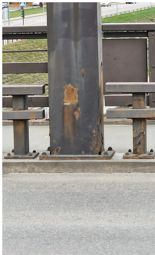
13.43 nuotrauka. Visų apšvietimo stulpų apačios stipriai pažeistos korozijos
