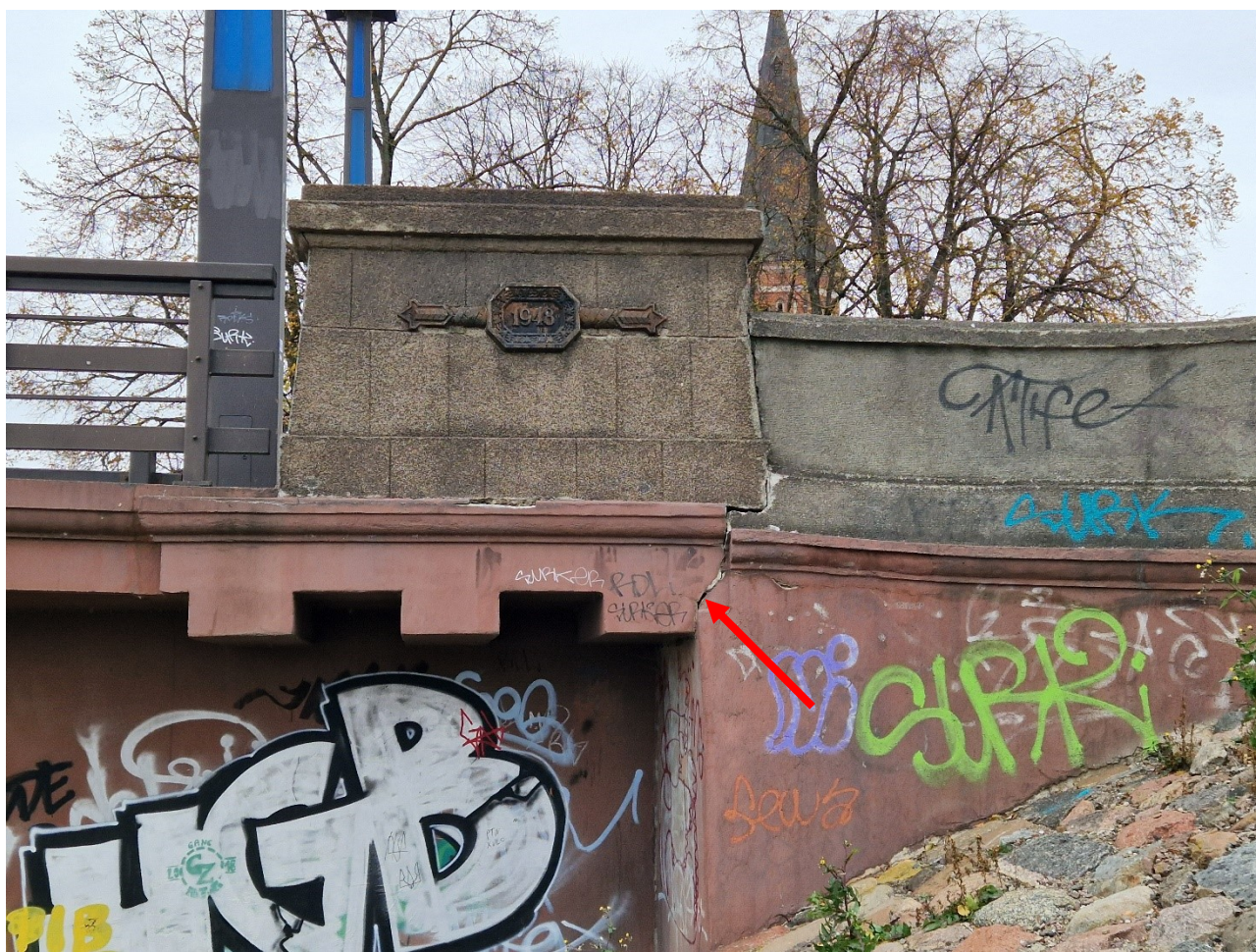
13.40 nuotrauka. Aukštupio pusėje VI atramos ramto g/b gembė atitrūkusi nuo prietilčio sparno ir atraminės sienos
