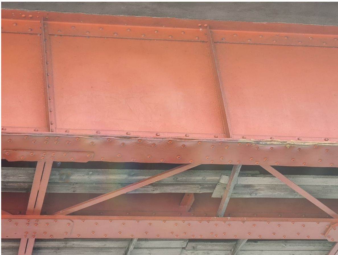
13.20 nuotrauka. Kraštinių sijų apatinės lentynos daugelyje vietų pasipūtusios, iš vidaus prasidėjęs korozijos procesas
