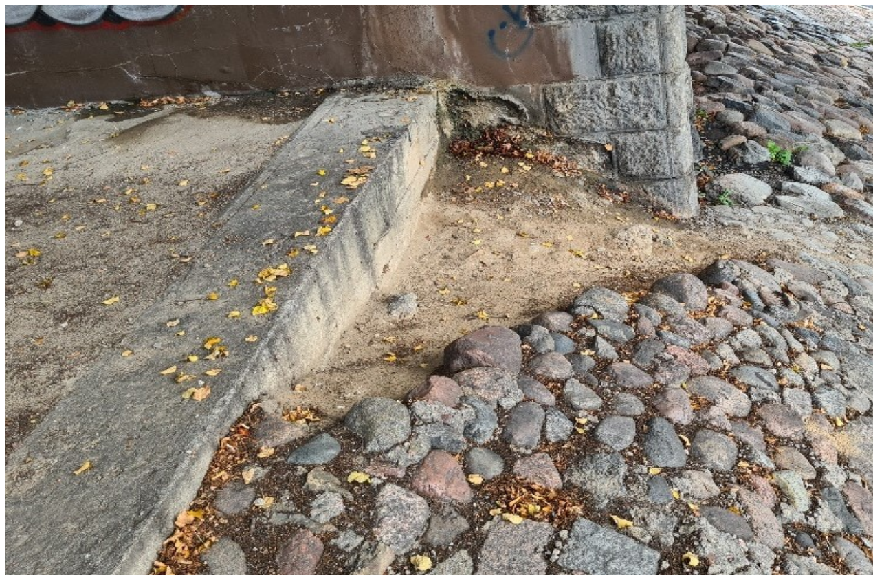
13.42 nuotrauka. Pairės kūgio šlaito sutvirtinimas žemupio pusėje ties VI atrama
