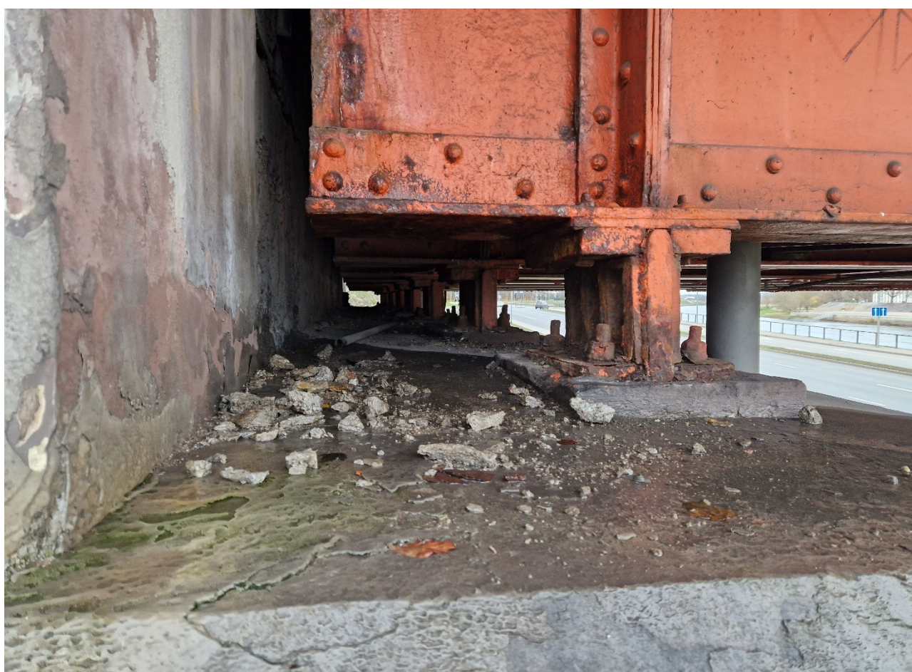
13.32 nuotrauka. Atraminių guolių bendras vaizdas virš I atramos. Dėl kiauro deformacinio pjūvio šlampa ramto rygelis, atkaltė ir atraminiai guoliai. Guolių metalinės detalės stipriai pažeistos korozijos
