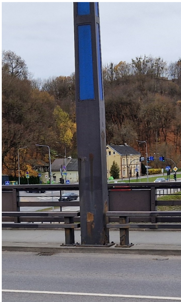
13.43 nuotrauka. Visų apšvietimo stulpų apačios stipriai pažeistos korozijos
