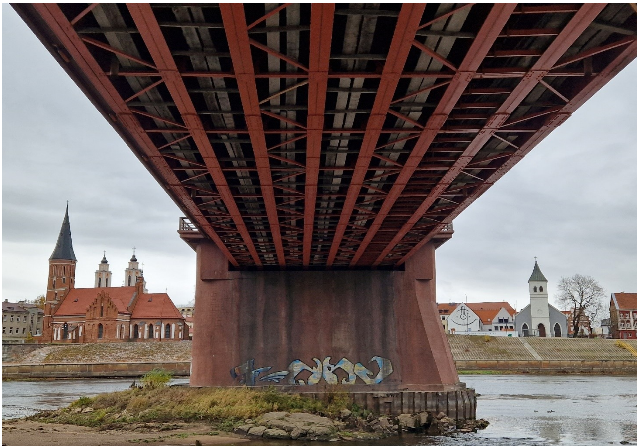
13.36 nuotrauka. III atramos bendras vaizdas žiūrint nuo II atramos. Palei atramą susidariusios akmenų sangrūdos, kemšasi upės vaga
