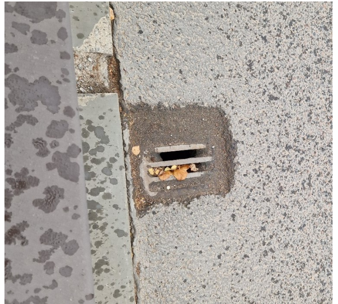
13.12 nuotrauka. Vandens nuvedimo šulinėlių bendras vaizdas aukštupio pusėje. Šulinėliai užsikimšę, vanduo nenuteka nuo dangos
