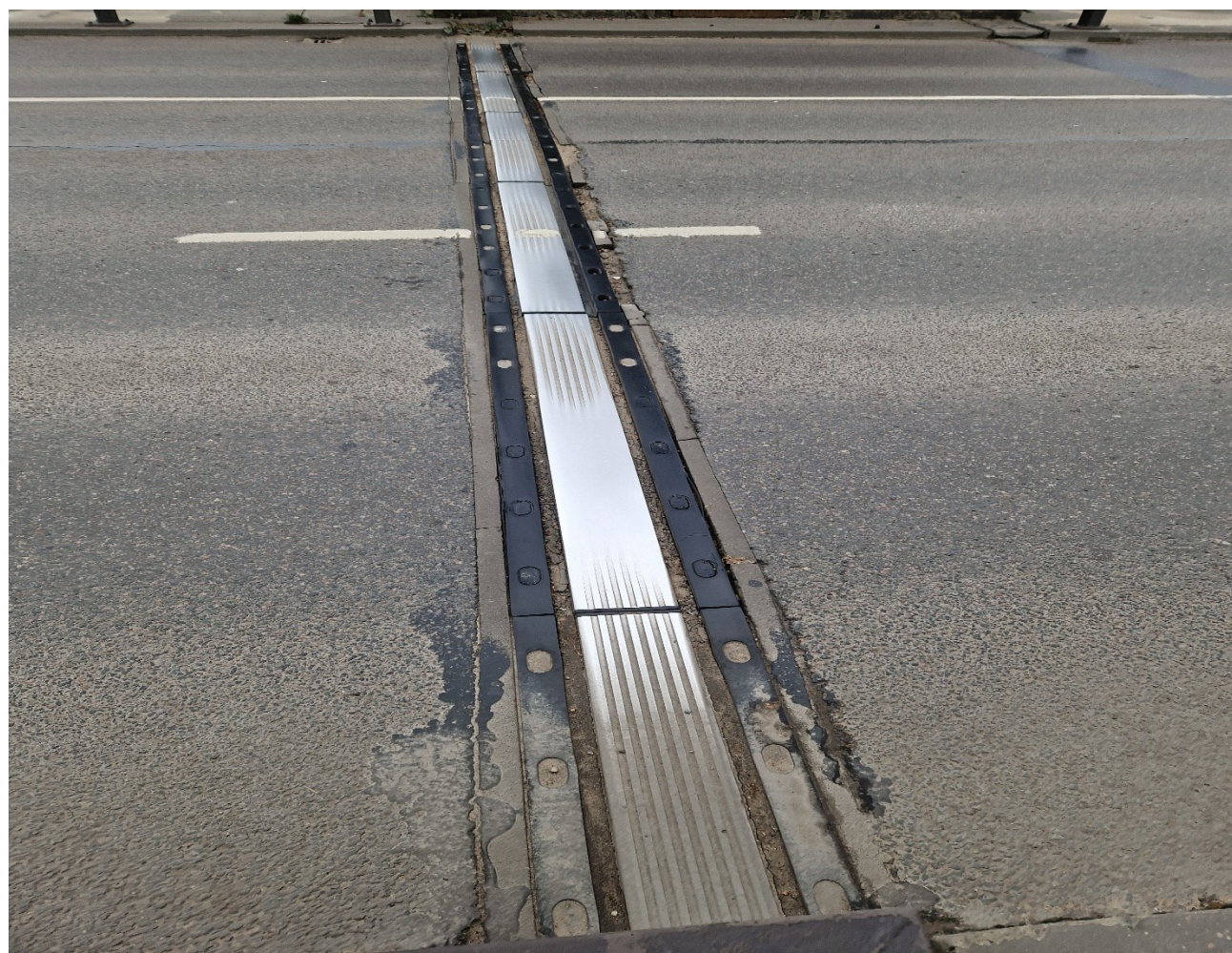
13.17 nuotrauka. Kiauras deformacinis pjūvis virš III atramos, sulaužytos pjūvio metalinės konstrukcijos, tarpai prinešti žemių ir šiukšlių
