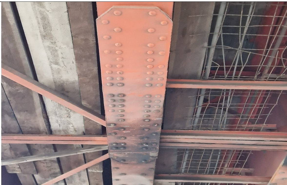
13.23 nuotrauka. Pirmojo tarpatramio perdangos 2 sijos virš važiuojamosios dalies mazginio lakšto bendras vaizdas žiūrint iš apačios. Mazge deformuotų kniedžių nėra, tačiau pažeista apsauginė dažų danga, todėl pradeda koroduoti metalinis lakštas
