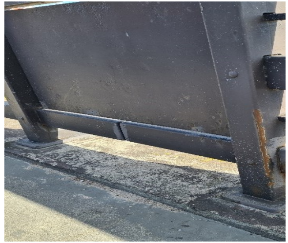
13.9 nuotrauka. Turėklų bendras vaizdas aukštupio pusėje. Lokaliuose metalinių elementų vietose prasidėję intensyvūs korozijos procesai
