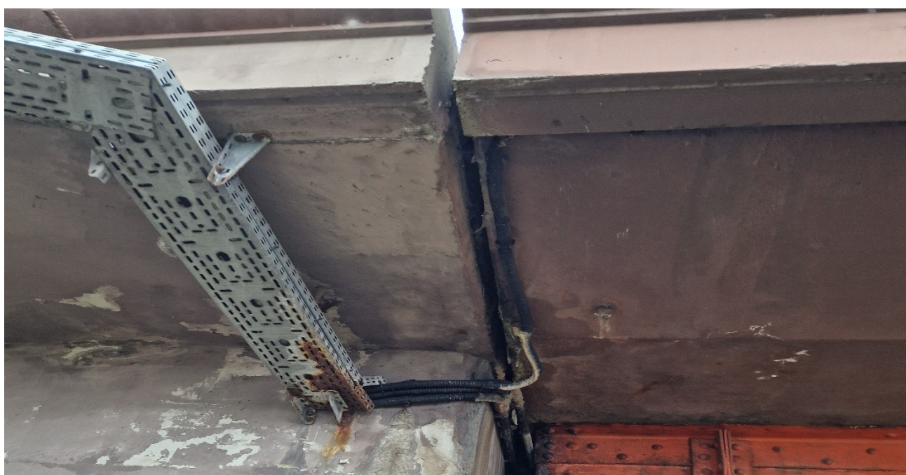
13.44 nuotrauka. Koroduoja ryšių kabelių laikikliai aukštupio pusėje ties I atrama
