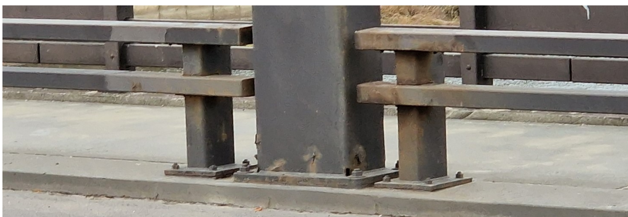
13.2 nuotrauka. Atitvarų bendri vaizdai. Daugelyje vietų korozijos pažeisti atitvarų vertikalūs ir horizontalūs elementai, didesni korozijos židiniai susiformavę ties elementų sujungimais ir mazgais. Taip pat korozijos pažeistos apšvietimo stulpų apačios
