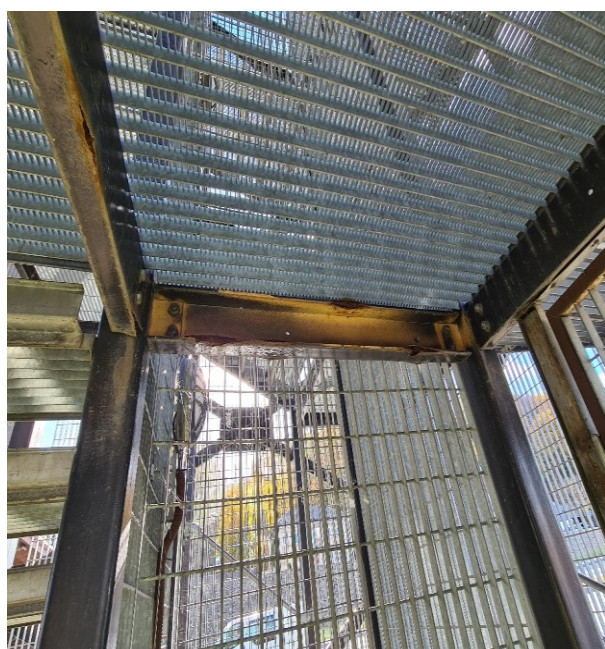
13.45 nuotrauka. Ties II atrama žemupio pusėje koroduoja laiptų karkasą laikantys plieniniai elementai
