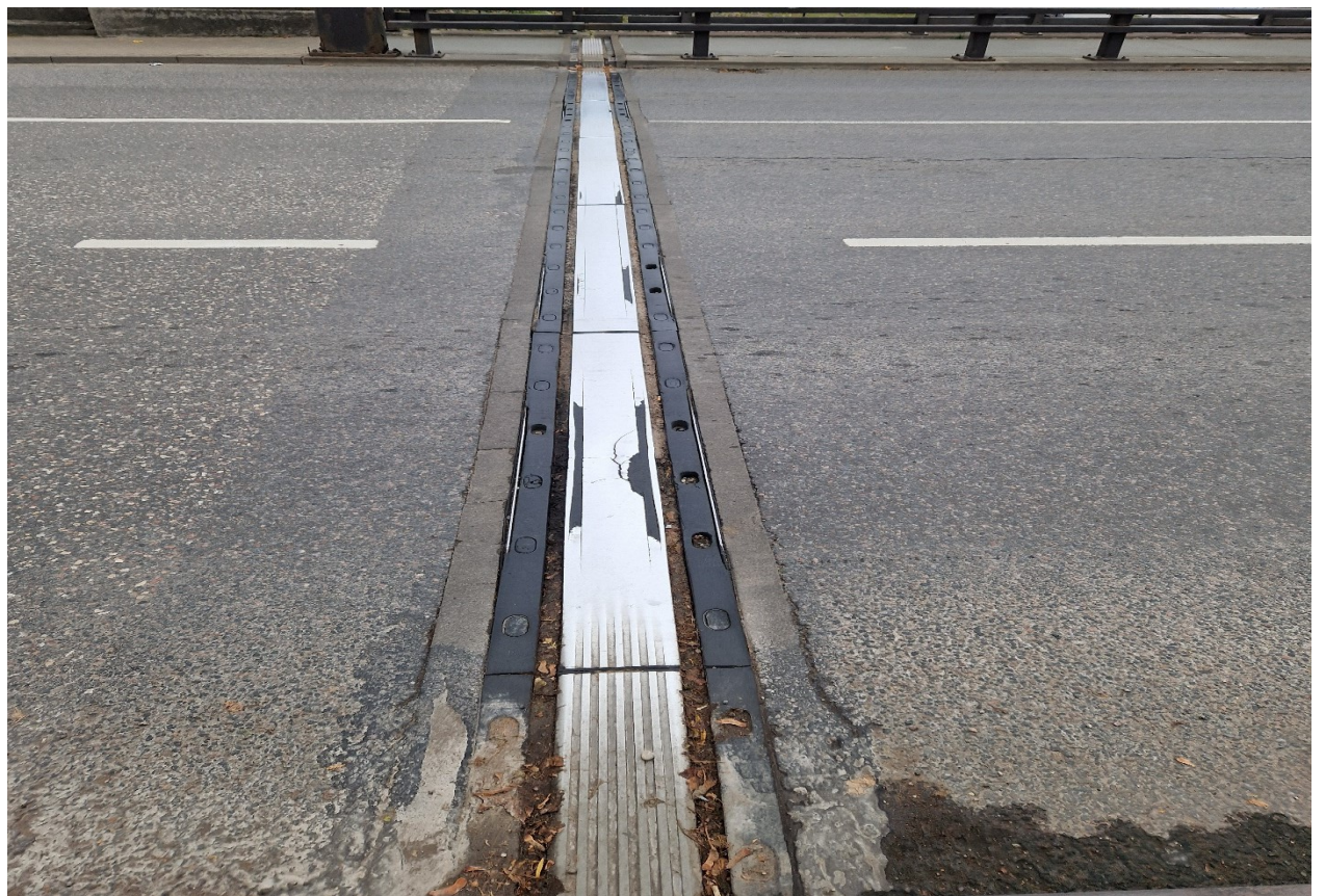
13.16 nuotrauka. Kiauras deformacinis pjūvis virš I atramos, sulaužytos pjūvio metalinės konstrukcijos, tarpai prieštėti žemių ir šiukšlių
