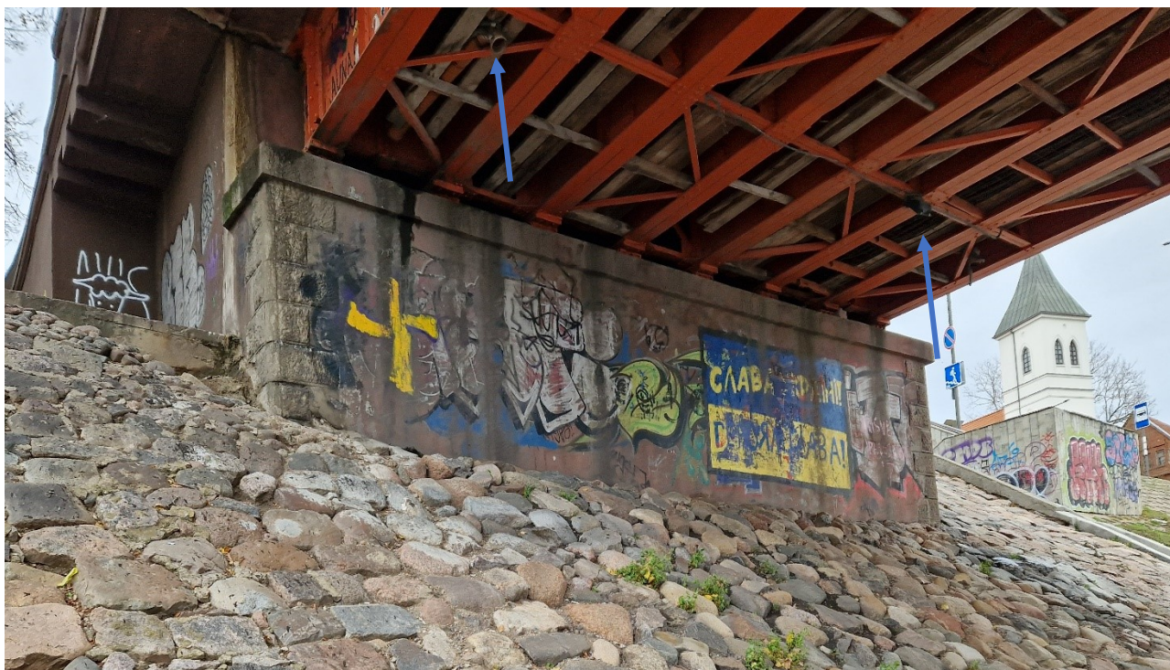
13.15 nuotrauka. Netinkamai įrengti vandens nuvedimo nuo dangos šulinėliai ties VI atrama. Trūksta vandens nuvedimo vamzdžių, iš šulinėlių ištekanis vanduo ardo žemiau esantį kūgio šlaito sutvirtinimą
