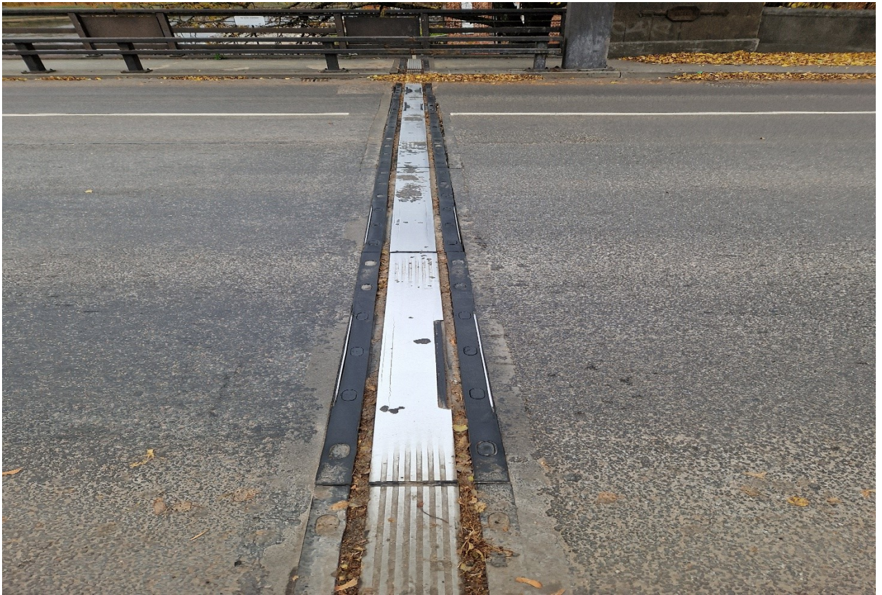
13.18 nuotrauka. Kiauras deformacinis pjūvis virš VI atramos, sulaužytos pjūvio metalinės konstrukcijos, tarpai prieštėti žemių ir šiukšlių
