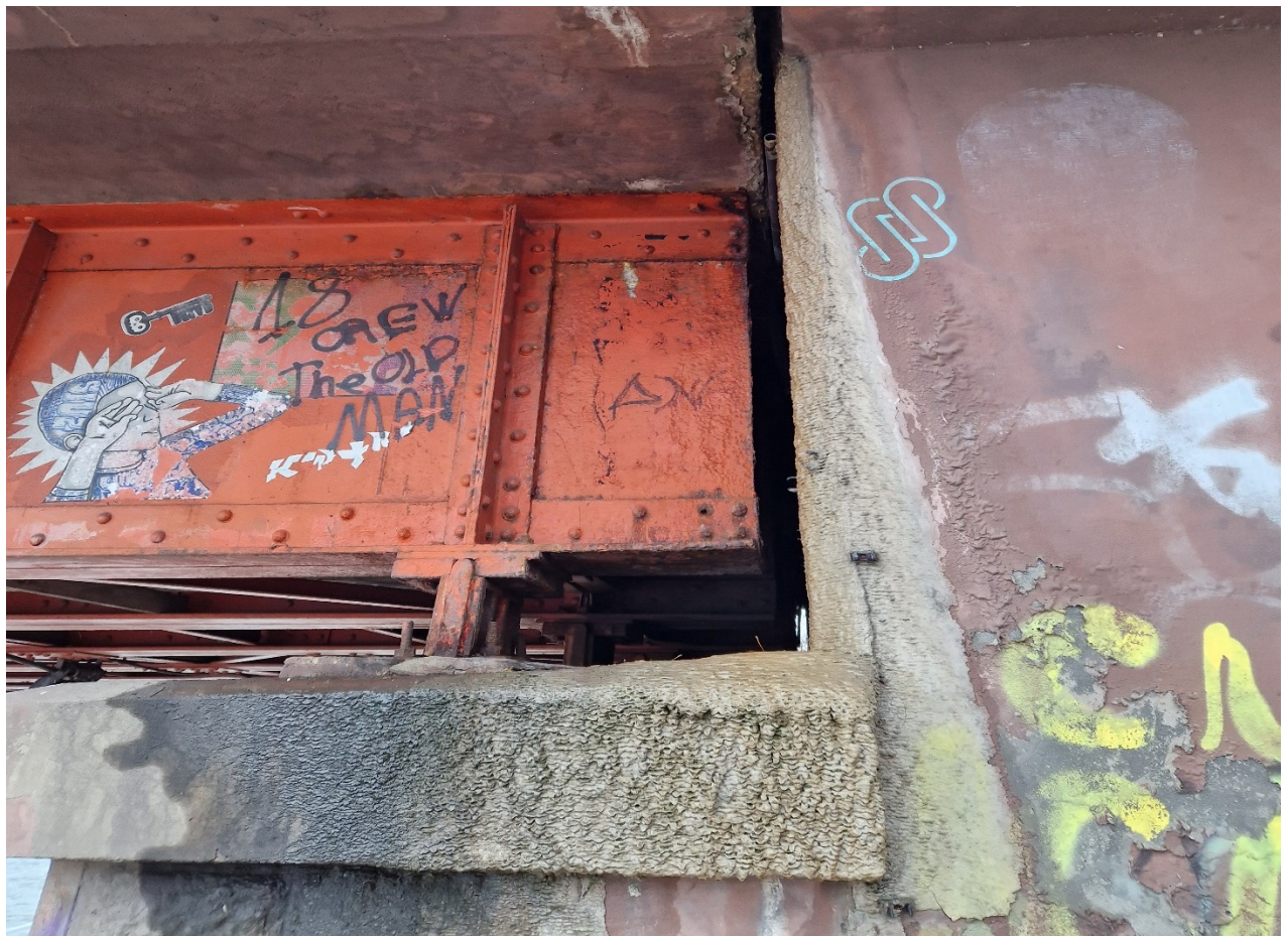
13.38 nuotrauka. VI atramos ir atraminių guolių bendras vaizdas. Dėl kiauro deformacinio pjūvio šlampa ramtas, perdangos sijų galai ir metaliniai atraminiai guoliai. Guoliuose pažeista apsauginė dažų danga, prasidėję intensyvūs korozijos procesai
