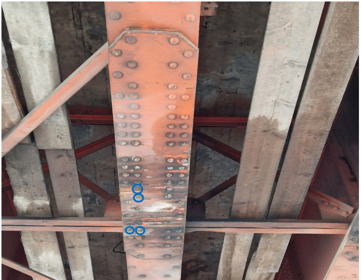
13.25 nuotrauka. Pirmojo tarpatramio perdangos 4 sijos virš važiuojamosios dalies mazginio lakšto bendras vaizdas žiūrint iš apačios. Mazge nukirptos 4 kniedžių galvutės, mazge nubrozdingtos 10 kniedžių galvutės
