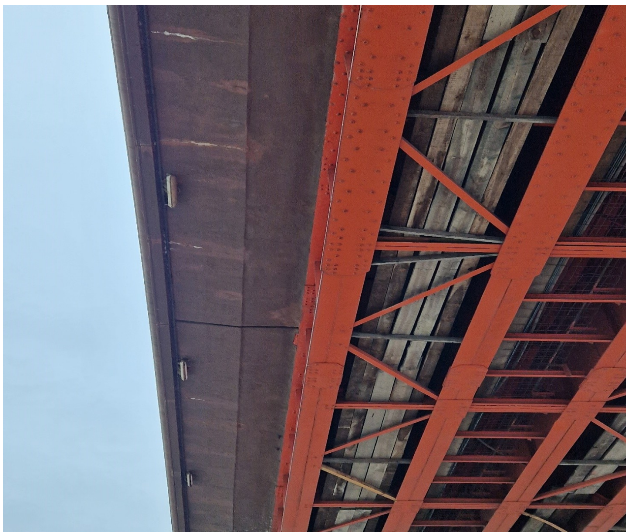
13.11 nuotrauka. Žemupio pusės šaltilčio bendras vaizdas iš apačias. Virš šaltilčio hidroizoliacija nėra sandari, nes jo apačioje matyti išsisunkę karbonatiniai produktai
