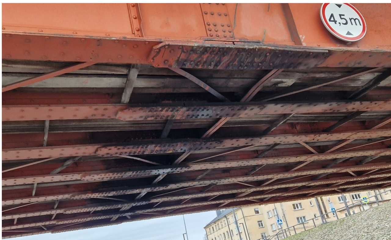
13.21 nuotrauka. Pirmojo tarpatramio perdangos sijų bendras vaizdas virš važiuojamosios dalies. Sijų apatinės lentynos ir jas jungiantys lakštai yra deformuoti negabaritinio transporto
