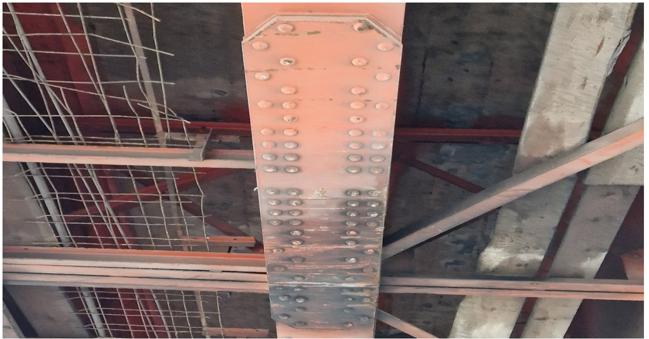
13.24 nuotrauka. Pirmojo tarpatramio perdangos 3 sijos virš važiuojamosios dalies mazginio lakšto bendras vaizdas žiūrint iš apačios. Mazge deformuotų kniedžių nėra, tačiau pažeista apsauginė dažų danga, todėl pradeda koroduoti metalinis lakštas
