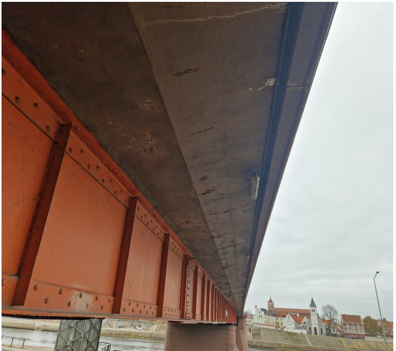
13.10 nuotrauka. Aukštupio pusės šalitilčio bendras vaizdas iš apačias. Virš šalitilčio hidroizoliacija nėra sandari, nes jo apačioje matyti išsisunkę karbonatiniai produktai
