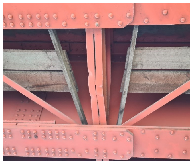
13.31 nuotrauka. Sijų ryšiai ir sijos po kiaurais deformaciniais pjūviais ir po blogai nuvestais vandens nuleidimu nuo hidroizoliacijos šulinėliais intensyviai koroduoja, pirmame tarpatramyje yra palankstytų ryšių
