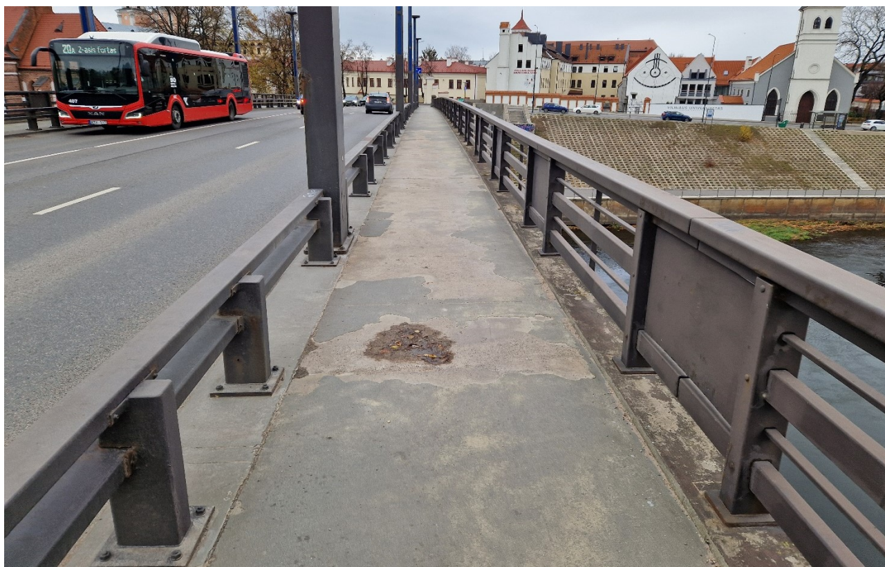
13.6 nuotrauka. Aukštupio pusės šalitilčio einamosios dalies dangos bendras vaizdas netoli VI atramos. Dideliais plotais atšokusi ir nusilupusi apsauginė danga
