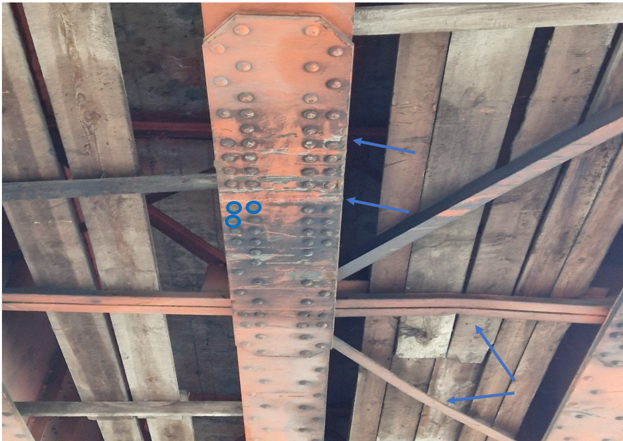
13.28 nuotrauka. Pirmojo tarpatramio perdangos 7 sijos virš važiuojamosios dalies mazginio lakšto bendras vaizdas žiūrint iš apačios. Mazge nukirptos 3 kniedžių galvutės, nubrozdintos 20 kniedžių galvutės ir pažeista apatinio lakšto apsauginė dažų danga bei apdaužytas lakšto kraštas žiūrint nuo žemupio pusės. Taip pat deformuota skersinė sija tarp 7 ir 8 pagrindinių išilginių sijų, bei deformuoti 2 horizontalių ryšių elementai
