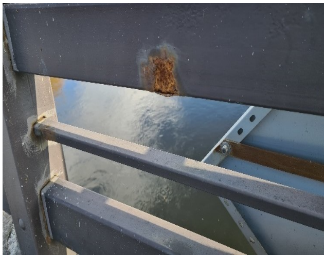
13.9 nuotrauka. Turėklų bendras vaizdas aukštupio pusėje. Lokaliuose metalinių elementų vietose prasidėję intensyvūs korozijos procesai
