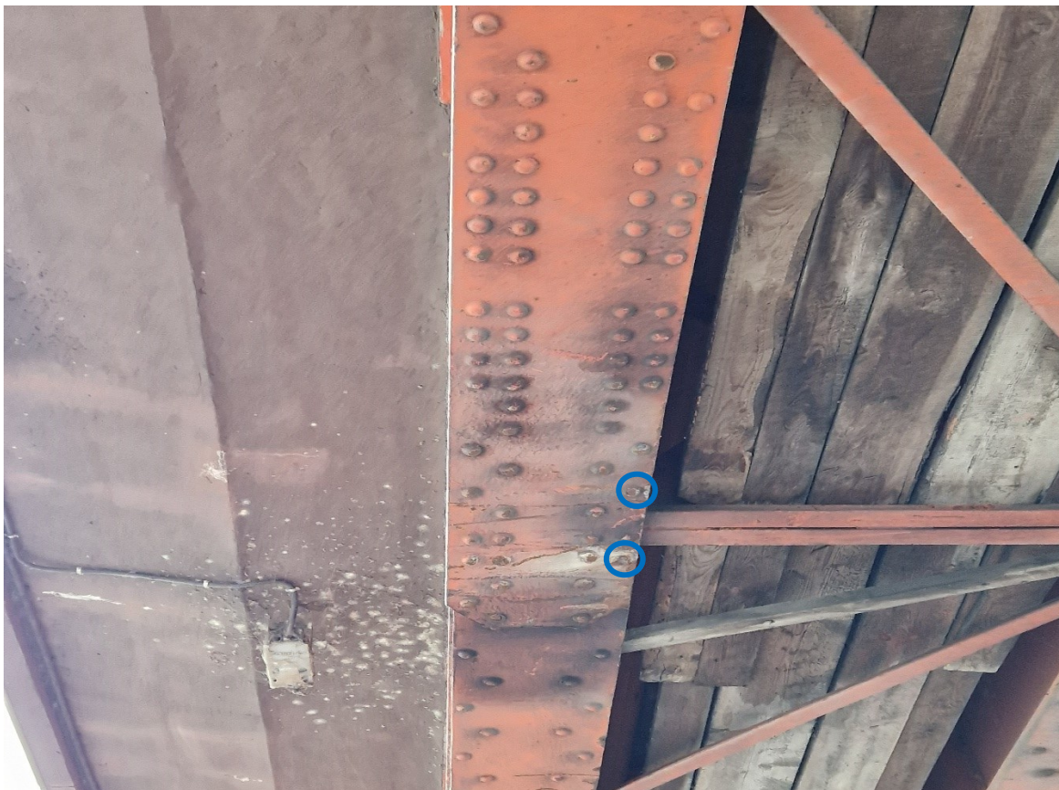
13.22 nuotrauka. Pirmojo tarpatramio perdangos 1 sijos virš važiuojamosios dalies mazginio lakšto bendras vaizdas žiūrint iš apačios. Mazge deformuotos dvi kniedės
