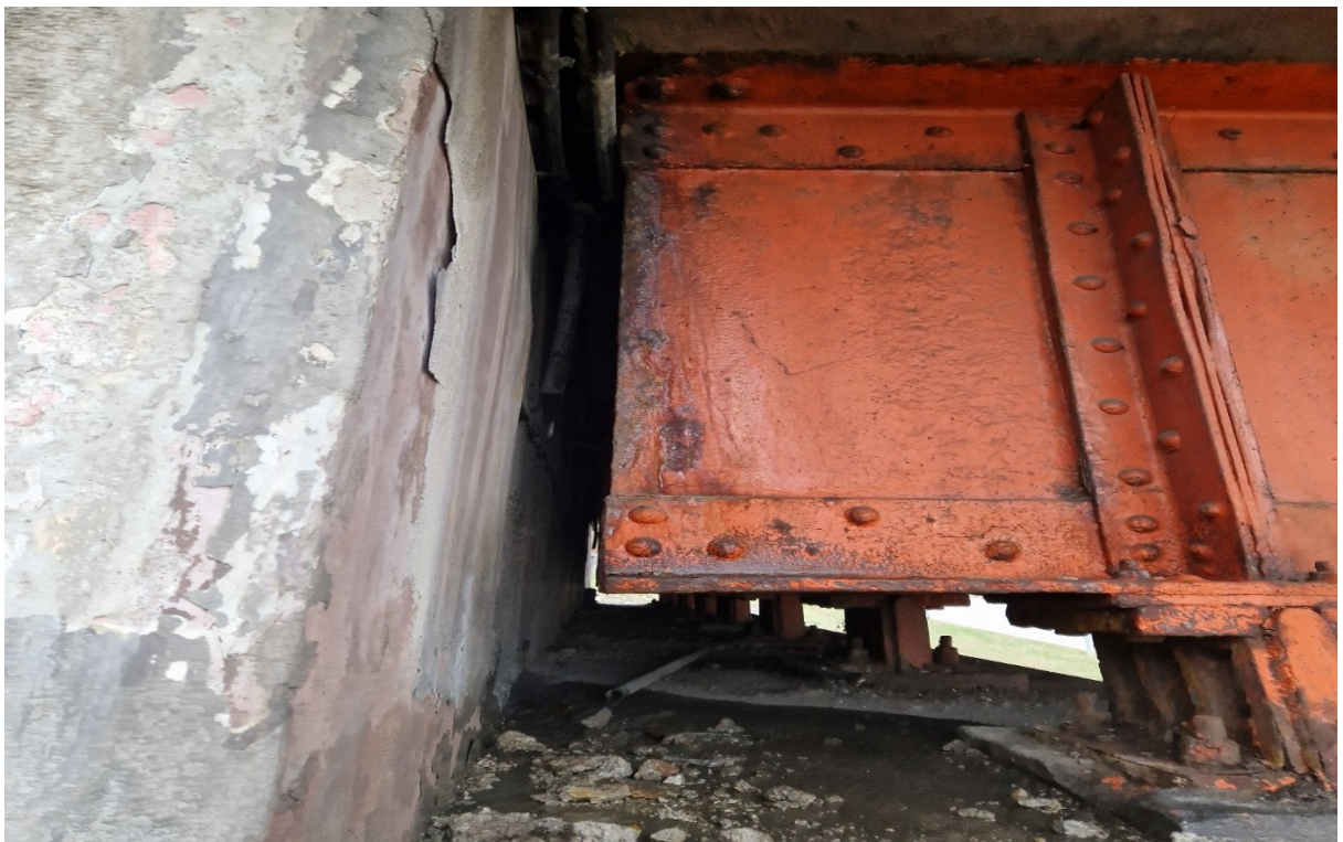
13.19 nuotrauka. Dėl kiauro deformacinio pjūvio šlampa perdangos sijų galai virš I atramos. Sijų galuose atsokusi apsauginė dažų danga, koroduoja metalinės konstrukcijos
