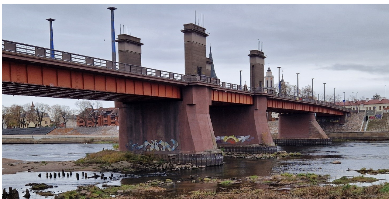
13.35 nuotrauka. III, IV ir V atramų bendri vaizdai žiūrint nuo aukščiau pusės. Atramų būklė gera, tačiau dėl kiauro deformacinio pjūvio virš III atramos jos fasadinėje dalyje matyti vandens tekėjimo žymės. III ir IV atramų fasadai išpaišyti grafiti
