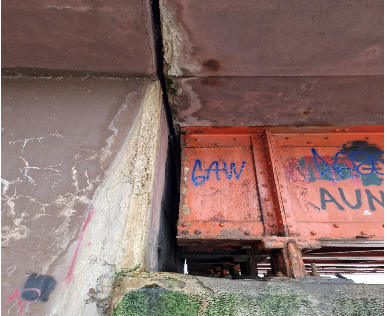
13.30 nuotrauka. Perdangos sijų galų bendras vaizdas virš VI atramos. Dėl kiauro deformacinio pjūvio šlampa perdangos sijų galai, ramto rygelis, atkaltė, atraminiai guoliai ir sparnas. Sijų galuose pažeista apsauginė dažų danga, koroduoja metalinės konstrukcijos
