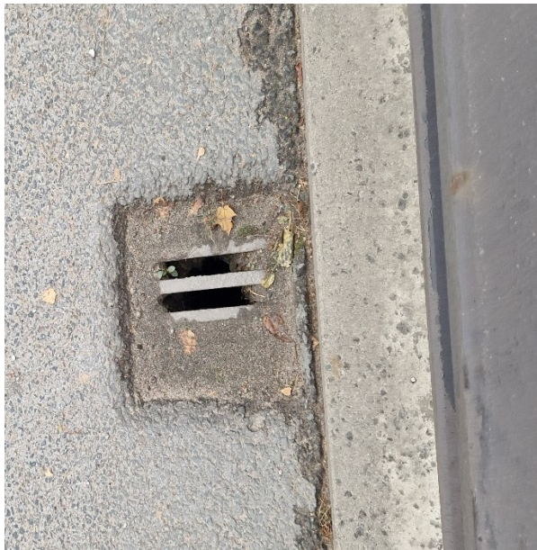
13.12 nuotrauka. Vandens nuvedimo šulinėlių bendras vaizdas aukštupio pusėje. Šulinėliai užsikimšę, vanduo nenuteka nuo dangos
