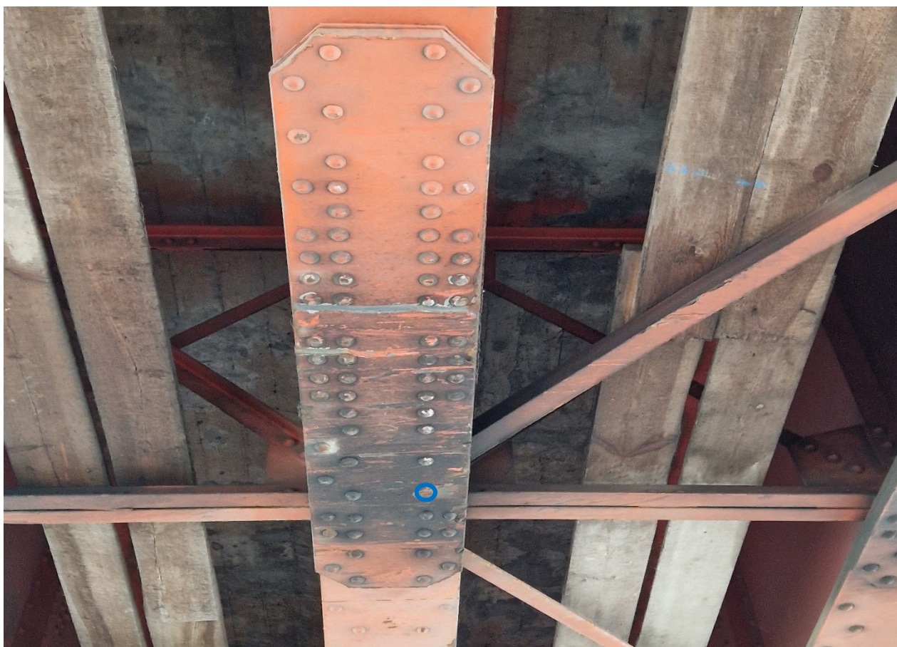
13.26 nuotrauka. Pirmojo tarpatramio perdangos 5 sijos virš važiuojamosios dalies mazginio lakšto bendras vaizdas žiūrint iš apačios. Mazge nukirpta 1 kniedės galvutė, nubrozintos 10 kniedžių galvutės ir pažeista apatinio lakšto apsauginė dažų danga
