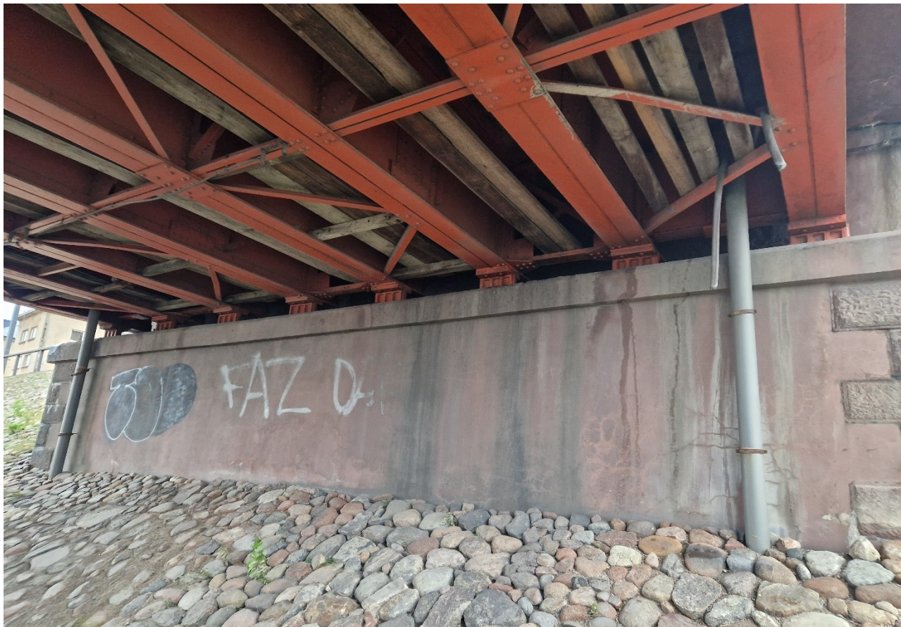
13.14 nuotrauka. Netinkamai įrengti vandens nuvedimo nuo hidroizoliacijos šulinėliai žemupio pusėje, ties I atrama
