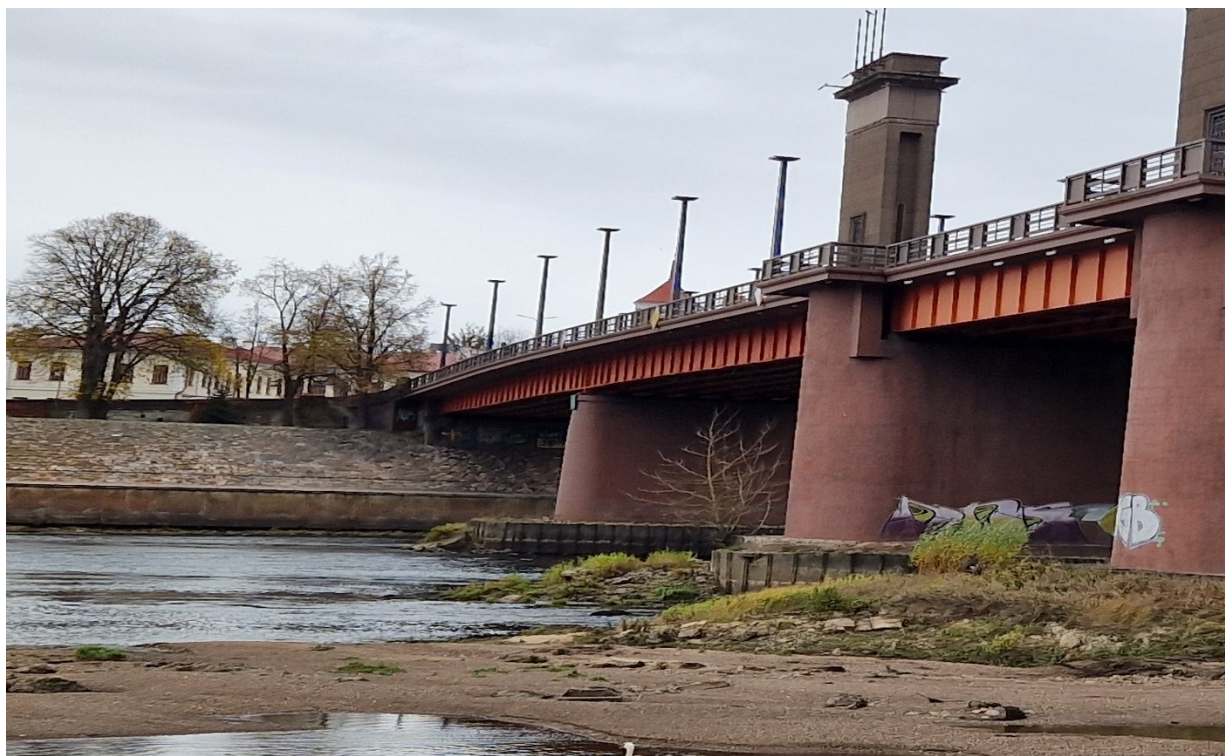
13.37 nuotrauka. IV atramos bendras vaizdas žiūrint nuo žemupio pusės. Palei atramą susidariusios akmenų sangrūdos, kemšasi upės vaga. Iš atramos, po tilto perdanga, auga medis
