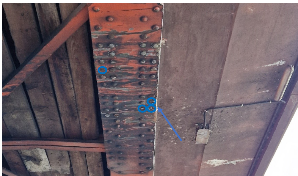
13.29 nuotrauka. Pirmojo tarpatramio perdangos 8 sijos virš važiuojamosios dalies mazginio lakšto bendras vaizdas žiūrint iš apačios. Mazge nukirptos 4 kniedžių galvutės, nubrozdintos 29 kniedžių galvutės ir pažeista apatinio lakšto apsauginė dažų danga bei apdaužytas lakšto kraštas žiūrint nuo žemupio pusės
