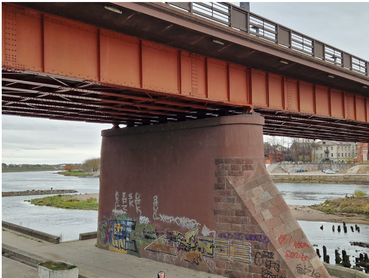
13.34 nuotrauka. II atramos ir atraminių guolių bendras vaizdas žiūrint nuo aukščiau pusės. Guoliai projektinėje padėtyje, jų būklė yra gera. Atramos būklė taip pat gera, tačiau jos fasadas apipaišytas grafiti dažais
