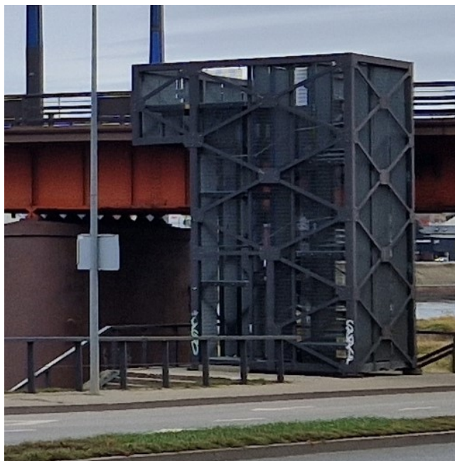
13.45 nuotrauka. Ties II atrama žemupio pusėje koroduoja laiptų karkasą laikantys plieniniai elementai
