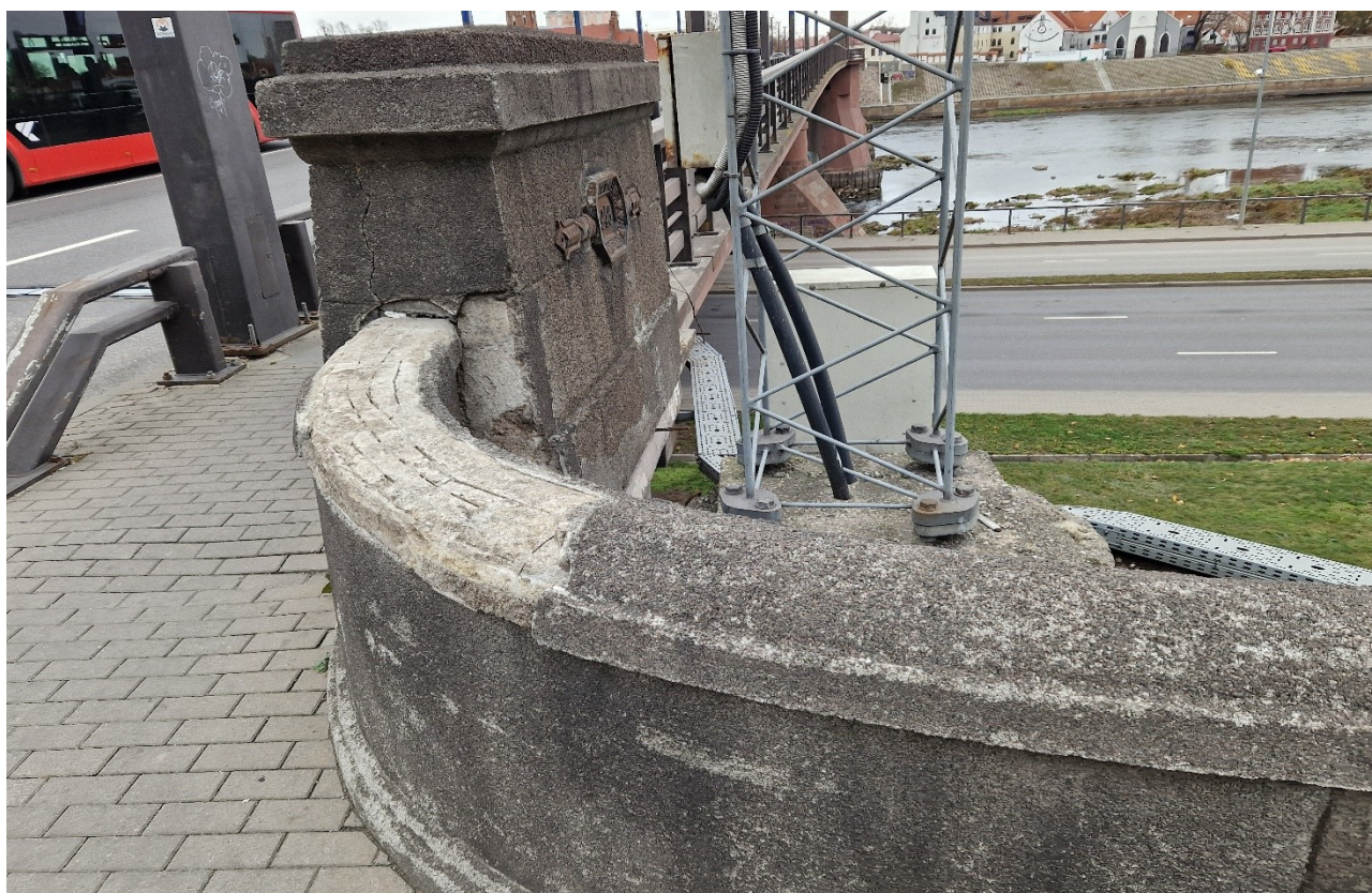
13.41 nuotrauka. Prietilčio g/b turėkle (aukštupio pusėje) nuiręs g/b porankis ties I atrama
