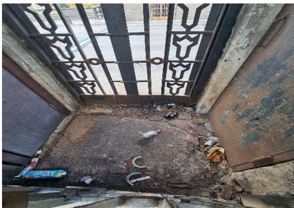
13.39 nuotrauka. Pilonai aptrupėję, apsamanoję, viduje ir išorėje pilna šiukšlių, apipaišyti grafiti
